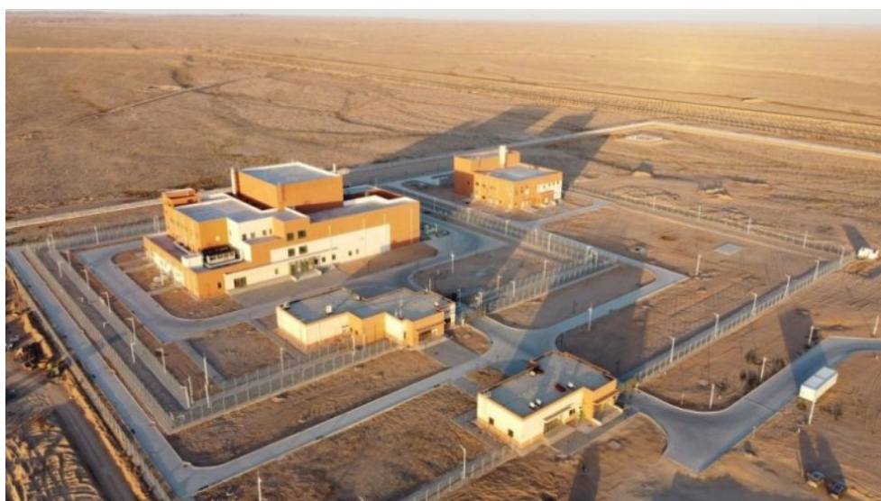
图 4-2 甘肃 2 兆瓦热功率液态燃料钍基熔盐实验堆
