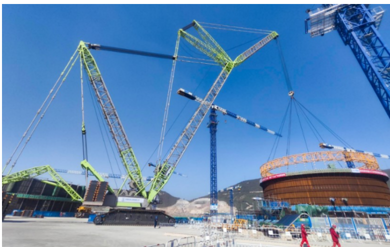
图 3-4 浙江金七门核电钢衬里模块化吊装
