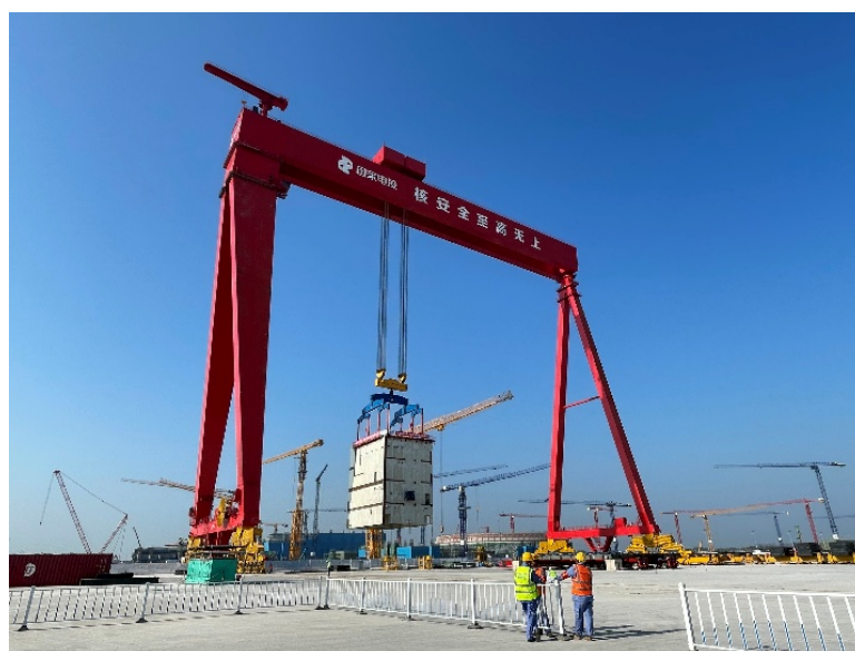
图 3-6 广东廉江核电应用龙门吊安装大型结构模块
